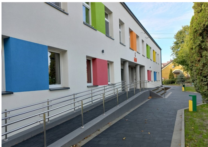
Zdjęcie 5. Obiekt gminny przy ul. ppłk. Srogiego w Busku-Zdroju po realizacji zadania
