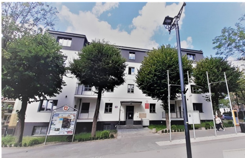
Zdjęcie 6. Budynek Urzędu Miasta i Gminy w Busku-Zdroju po zakończeniu prac
