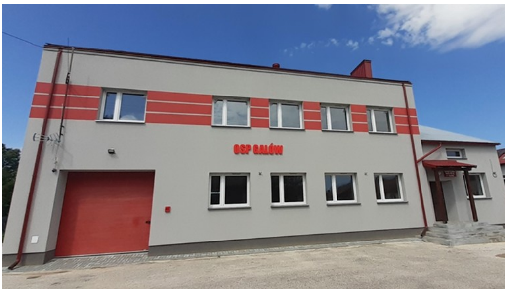
Zdjęcie 7. Budynek świetlicy wiejskiej i Strażnicy OSP w Galowie
