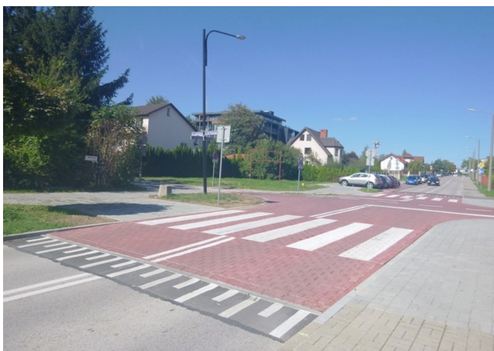
Zdjęcie 4. Wyniesione przejście dla pieszych na skrzyżowaniu ulic Armii Krajowej i Bohaterów Westerplatte
